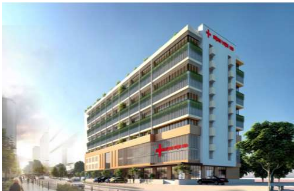
Khu nhà Bệnh viện 199 giai đoạn 2
